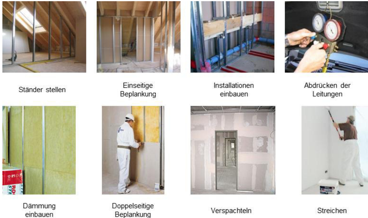
Abbildung 2: Prozesse zur Erstellung einer Trockenbauwand
